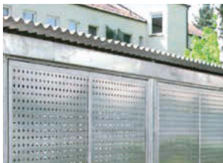
Fahrradhaus mit Dacheindeckung Stahlwellblech
