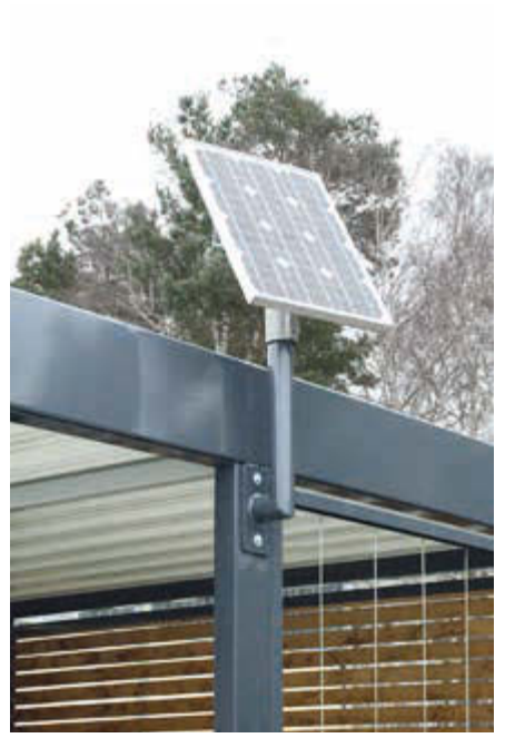
▲ Solarmodul an Warthallenstütze befestigt
