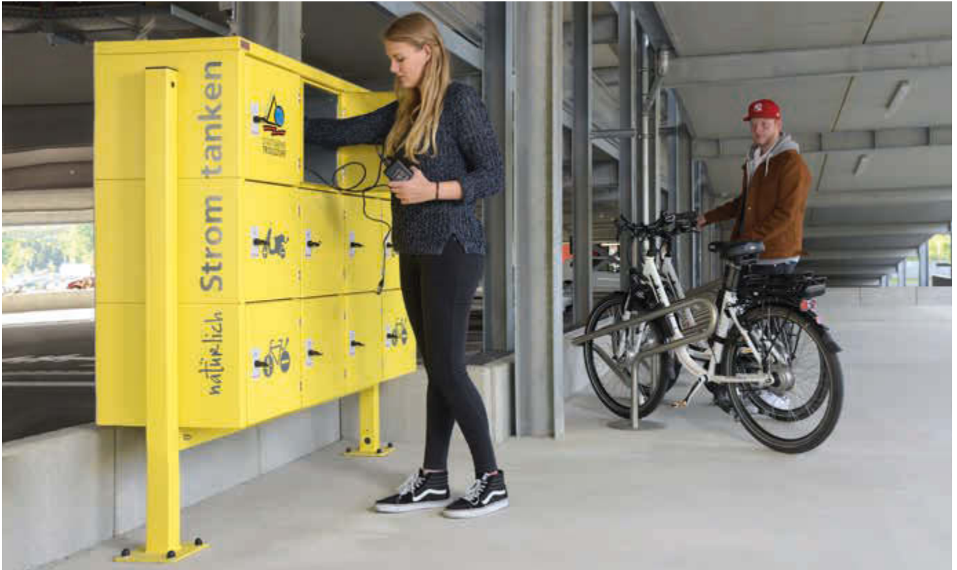
Schließfachanlage SECURE, 12 Schließfächer mit Elektroinstallation, Türschließung mittels Münzpfandschloss, inklusive Unterzug und Stützen zum Aufdübeln, Stahlkonstruktion in RAL 1018 zinkgelb, Beklebung bauseits
