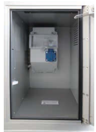
▲ Innenansicht Schließfach mit Elektroinstallation
