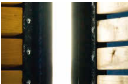
▲ Stützenblende hinterleuchtet mit LED-Lichtleiste
