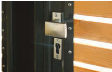
▲ Schiebetür geschlossen, Innenansicht, Drückergarnitur drehbarer Knauf
