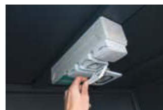
▲ Steckdosenleiste inklusive LED-Strahler und Dämmerungsschalter
