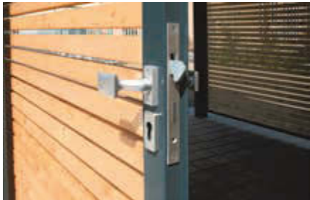
▲ Hakenschloss für Schiebetür, Außenansicht, Drückergarnitur fester Knauf
