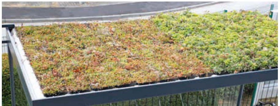
▲ links: Dachbegrünungssystem Economy, rechts: Dachbegrünungssystem Premium
