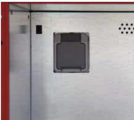
▲ Detail: Aufputz-Schuko-Steckdose (Elektroinstallation) 230 V mit Deckel, Schutzart IP 44
