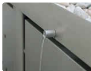
▲ Detail: Ablaufröhrchen nach außen (hinten)
