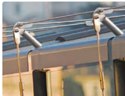
▲ Detail: Spannvorrichtung mittels Gewindestangen aus Edelstahl
