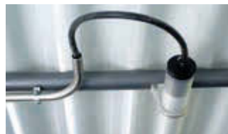
▲ Leerrohrsystem für Leuchtenverkabelung: Edelstahl, rostfrei, für elektrische Leitungsführung (z. B. NYM-J 3 x 1,5 mm²) inkl. Befestigungsmaterial (ohne Verkabelung)
