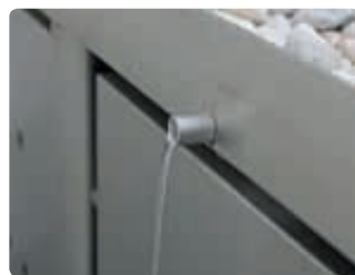
▲ Detail: Ablaufröhrchen nach außen (hinten)
