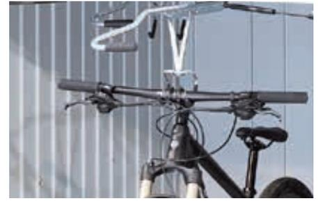
▲ Detail: Fahrradhängeschiene aus feuerverzinktem Stahlblech
