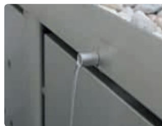
▲ Detail: Ablaufröhrchen nach außen (hinten)
