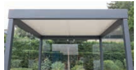
▲ Detail: Dachunterseite aus Sandwichelementen
