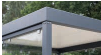
▲ Detail: Stützenverbindung mittel Edelstahlschrauben
