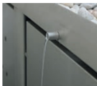
▲ Detail: Ablaufröhrchen nach außen (hinten)
