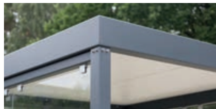
▲ Detail: Stützenverbindung mittel Edelstahlschrauben
