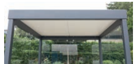
▲ Detail: Dachunterseite aus Sandwichelementen
