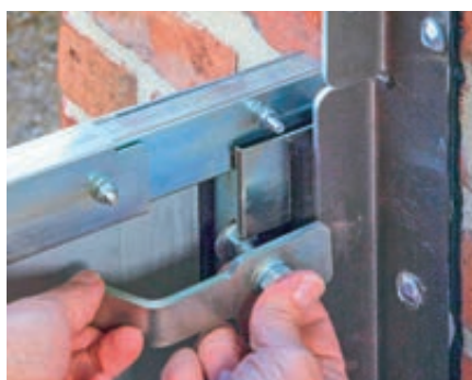
▲ Dichtungen werden mittels Stahlflanschen komprimiert
