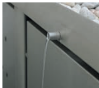
▲ Detail: Ablaufröhrchen nach außen (hinten)
