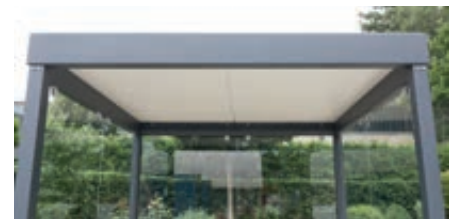
▲ Detail: Dachunterseite aus Sandwichelementen
