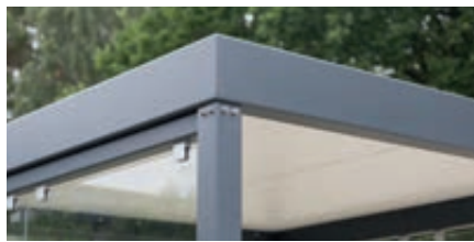
▲ Detail: Stützenverbindung mittel Edelstahlschrauben
