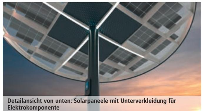
Detailansicht von unten: Solarpaneele mit Unterverkleidung für Elektrokomponente
