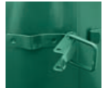
▲ Detail: Bügelverschluss
