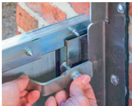
▲ Dichtungen werden mittels Stahlflanschen komprimiert
