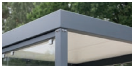
▲ Detail: Stützenverbindung mittel Edelstahlschrauben
