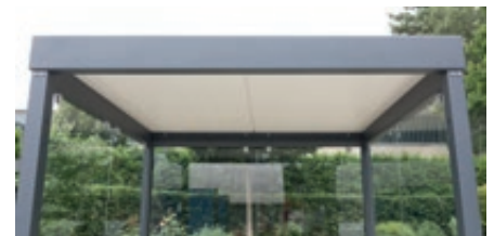
▲ Detail: Dachunterseite aus Sandwichelementen
