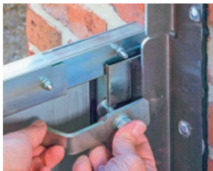
▲ Dichtungen werden mittels Stahlflanschen komprimiert
