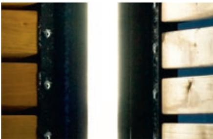
▲ Stützenblende hinterleuchtet mit LED-Lichtleiste
