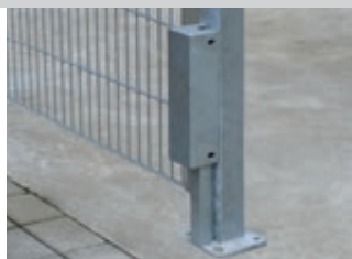
▲ Detail: Anschlusskasten mit Blechummantelung, feuerverzinkt
