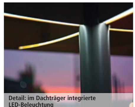
Detail: im Dachträger integrierte LED-Beleuchtung
