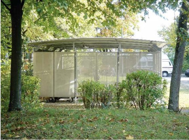
Wertstoffumhausung BWA bausystem® Dachbreite x Dachtiefe 5200 mm x 2300 mm, Stahlkonstruktion feuerverzinkt inkl. Rück-, Seiten- und Frontwand mit Tür aus Holzlamellen, Dacheindeckung Stahlwellblech
