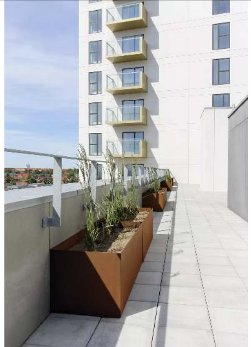
Pflanzbehälter LINN, rechteckig, aus Cortenstahl
