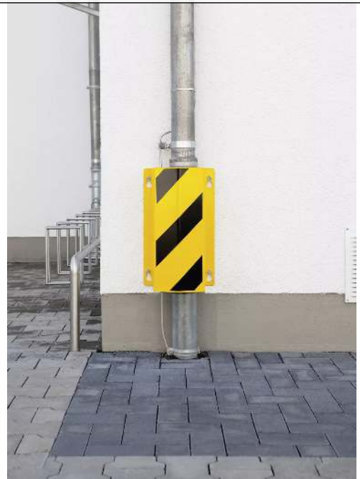
Rohrschutzbügel AUTUN, Höhe 500 mm, in RAL 1023 verkehrsgelb
