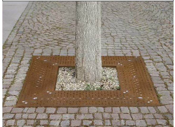
Baumschutzrost TABER, Breite x Tiefe 1000 x 1000 mm, Unterkonstruktion verzinkt, Blechprofil-Segmente mit Prägung City aus Cortenstahl
