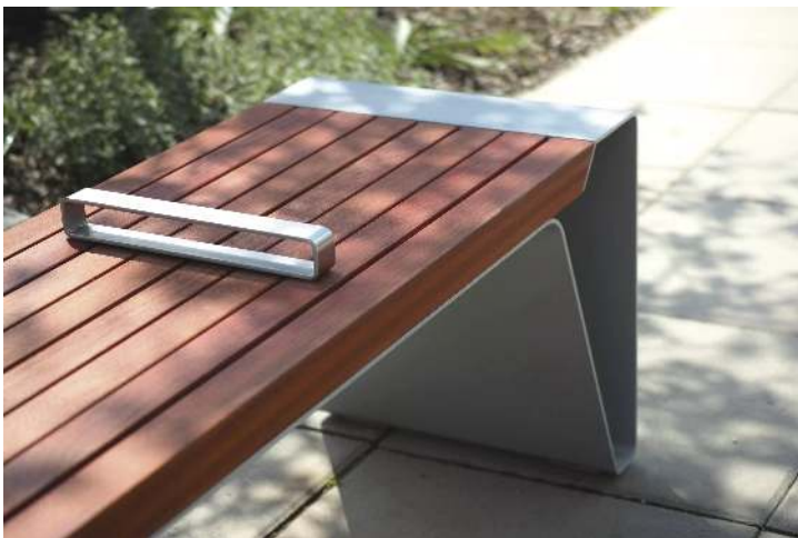
Detail: Sitzfläche, mit Jatobaholzbelattung, mit Edelstahlstreben
