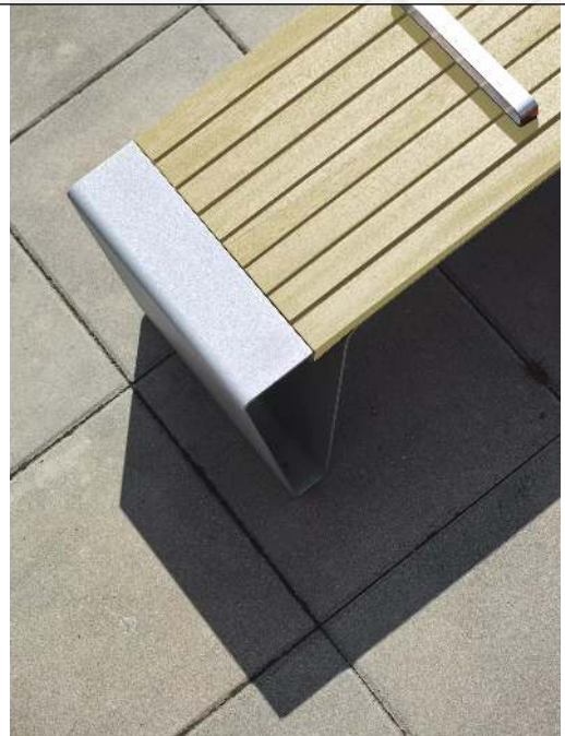
Detail: Sitzfläche, mit Robinienholzbelattung, mit Edelstahlstreben
