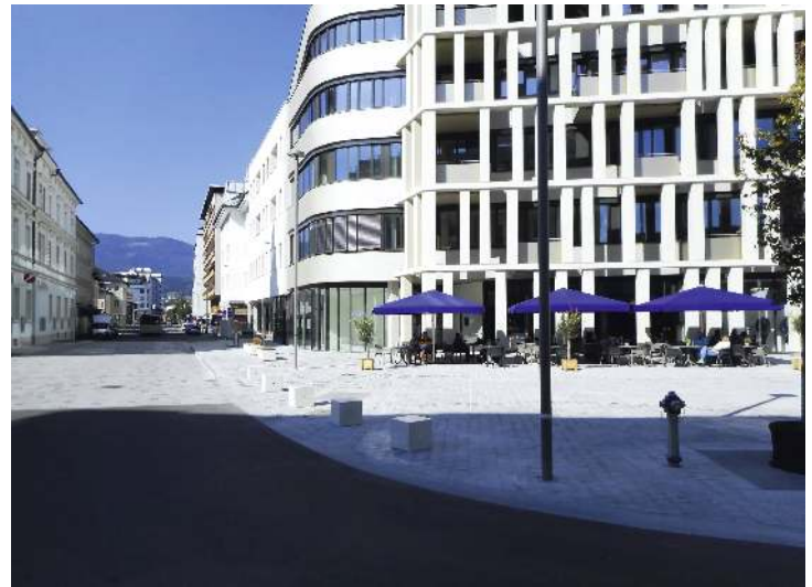
Poller IDRA aus Beton, Oberseite geschliffen, in Granitoptik weiß
