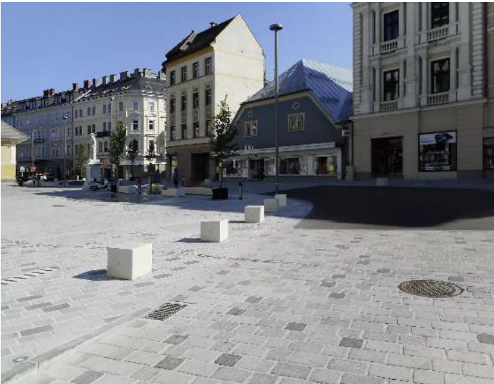
Poller IDRA aus Beton, Oberseite geschliffen, in Granitoptik weiß
