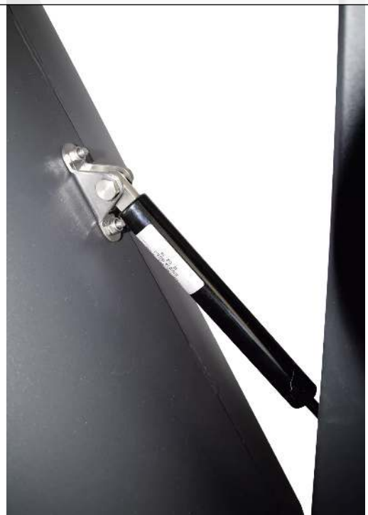
Detail: Gaszugfeder
