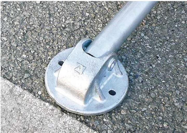
Detail: Fußplatte mit Bodenplatte
