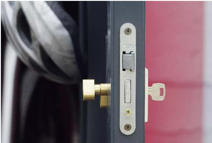
Detail: Schließsystem mit stabilem Einsteckschloss und innenliegender Notentriegelung
