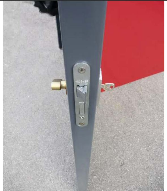
Detail: Schließsystem mit stabilem Einsteckschloss und innenliegender Notentriegelung
