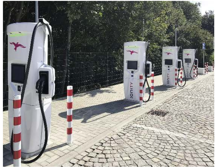
Rammschutzpoller GENAS zum Einbetonieren, Ø 89 mm, in weiß mit roten Reflexstreifen
