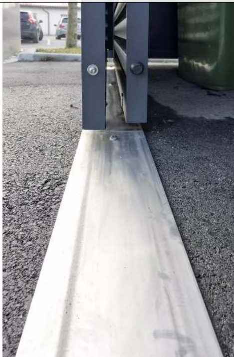
Bodenblech für Schiebetüren
