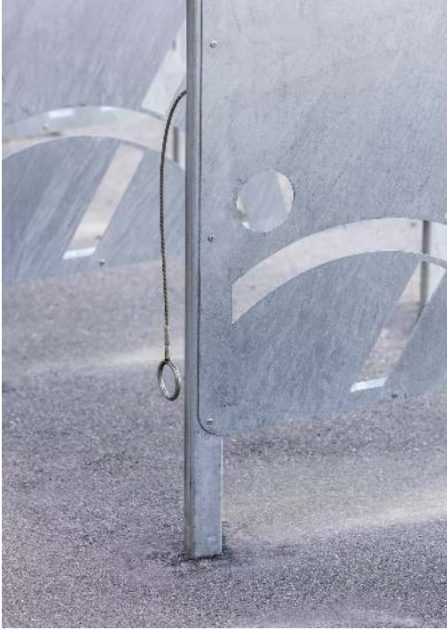
Detail: Stahlseil (Ø 5 mm) mit Stahlring
