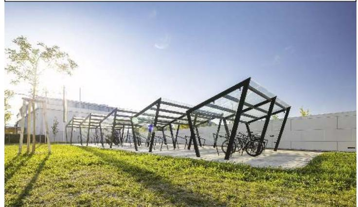
Fahrradüberdachung EDGE, einseitig, Dachbreite x Dachtiefe 3900 mm x 2500 mm, Dacheindeckung VSG, Klarglas, auftragsbezogenes Scheibendekor in der Seitenscheibe, mit Anlehnbügel EDGETYRE, Stahlkonstruktion in RAL 7016 anthrazitgrau
