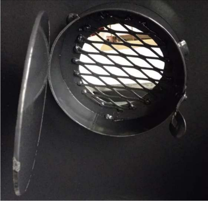
Detail: Bodenklappe Ascher geöffnet
