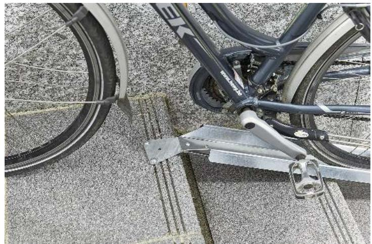
Detail: Befestigung durch Aufdübeln
