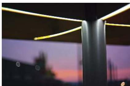
Oberfläche Stahlteile : feuerverzinkt und pulverbeschichtet
