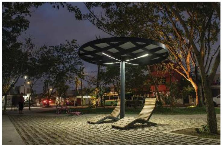
Detail: im Dachträger integrierte LED-Beleuchtung
