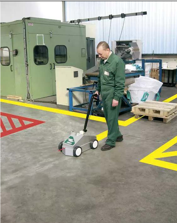
Markierungen im Innenbereich
