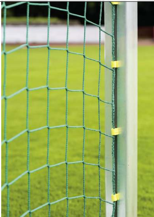
Profil mit Nut für Kunststoffnetzhalter
