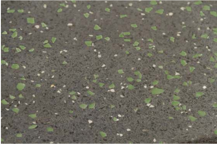
Detail: Beton schwarz mit grün lumineszierenden Partikeln
